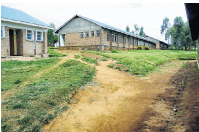
Ein Blick von außen: So sieht die Lutheran Secondary School in der 30 000 Einwohner zählenden Provinzhauptstadt Bukoba aus.
