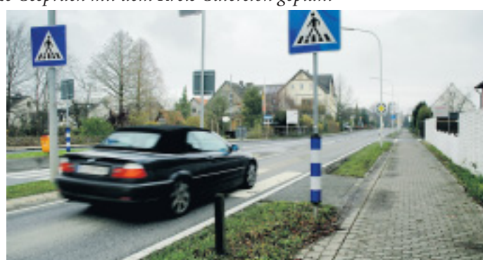
Soll ausgebaut werden: Die Theenhausener Straße zwischen der Buswendeschleife und der Straße Voßheide. FOTO: A. HANNEFORTH
