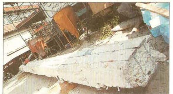
Schwerstarbeit: Solche massiven Träger haben die Bauarbeiter aus dem 1951 errichteten Altbau geholt. Fotos: Marco Purkhart
