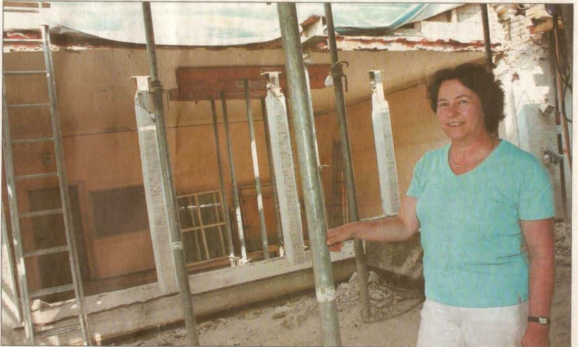
Ein großes Loch in der Schulwand: Um eine Verbindungsbrücke zwischen dem Altbau und dem geplanten Neubau am Gymnasium installieren zu
