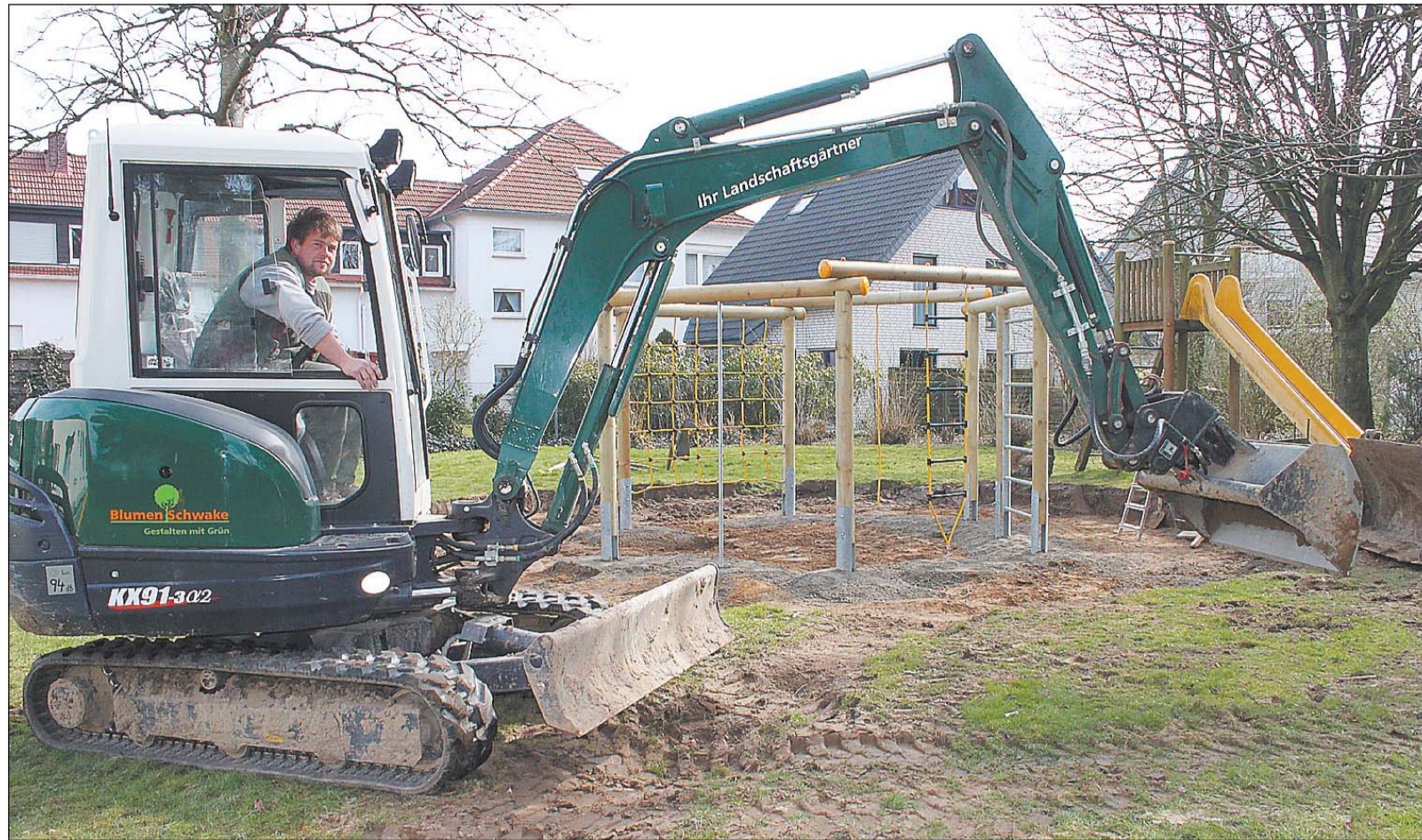
Ralph Diekmann und seine Kollegen haben auf dem Spielplatz an der Hermannstraße ein neues Klettergerüst aufgebaut. Ein weiteres Spielplatz installiert werden. Foto: Dunja Delker
