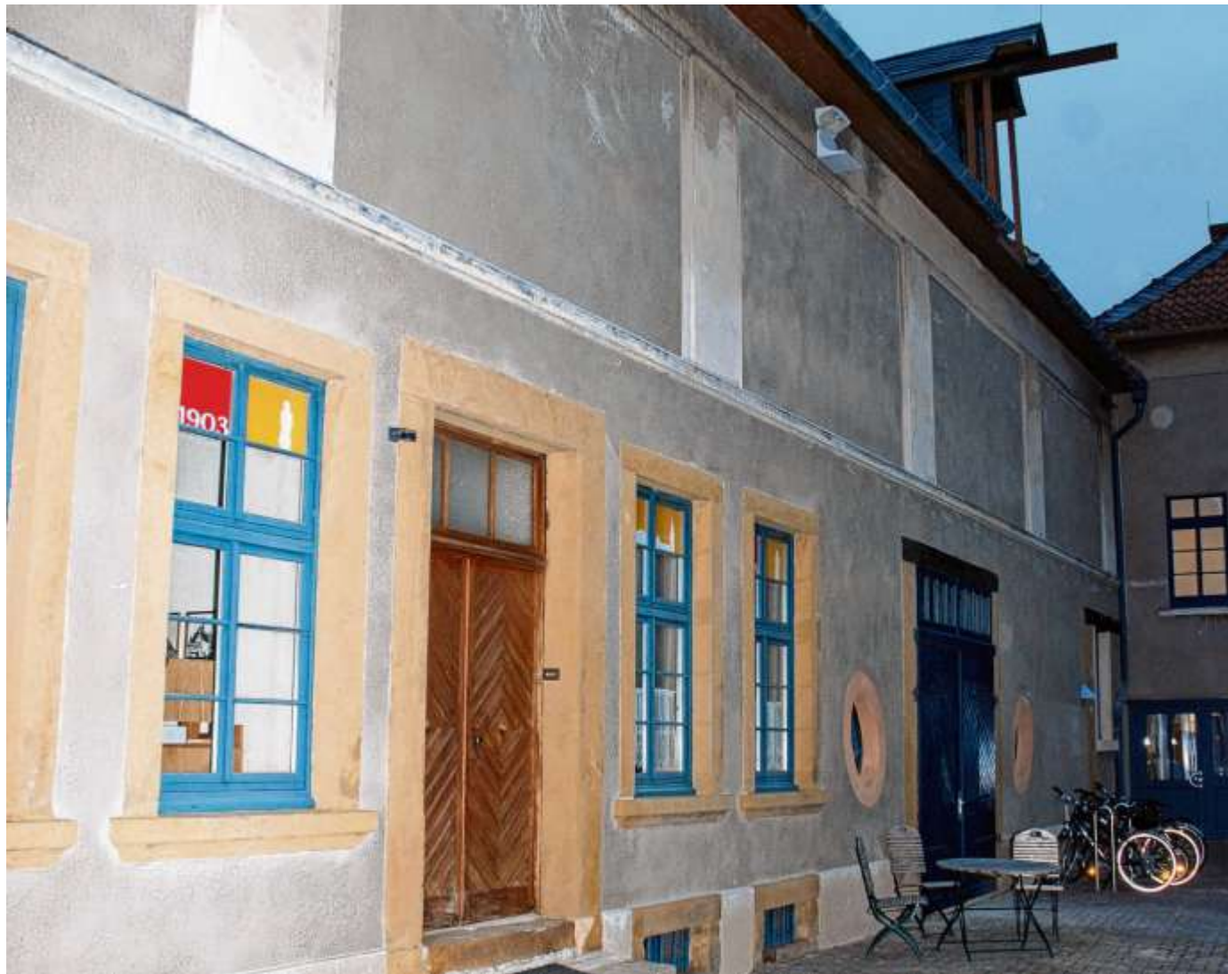
Im neuen Glanz: Der Putz des Fabrikgebäudes am Haus Werther ist frisch saniert, der Sandstein wurde gereinigt. FOTO: D. H. SEROWY
