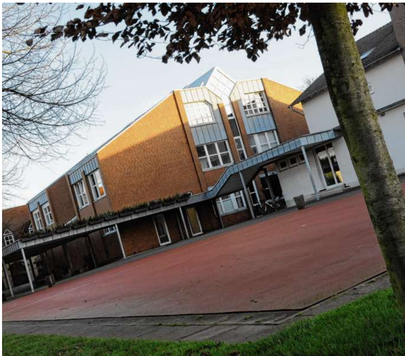
Wertvoller Boden: Das Grundstück, auf dem das Evangelische Gymnasium – hier das Schulgebäude und ein Teil der Sporthalle – steht, dürfte mehr als eine Million Euro wert sein. Eigentümer ist bisher die evangelische Kirchengemeinde.
