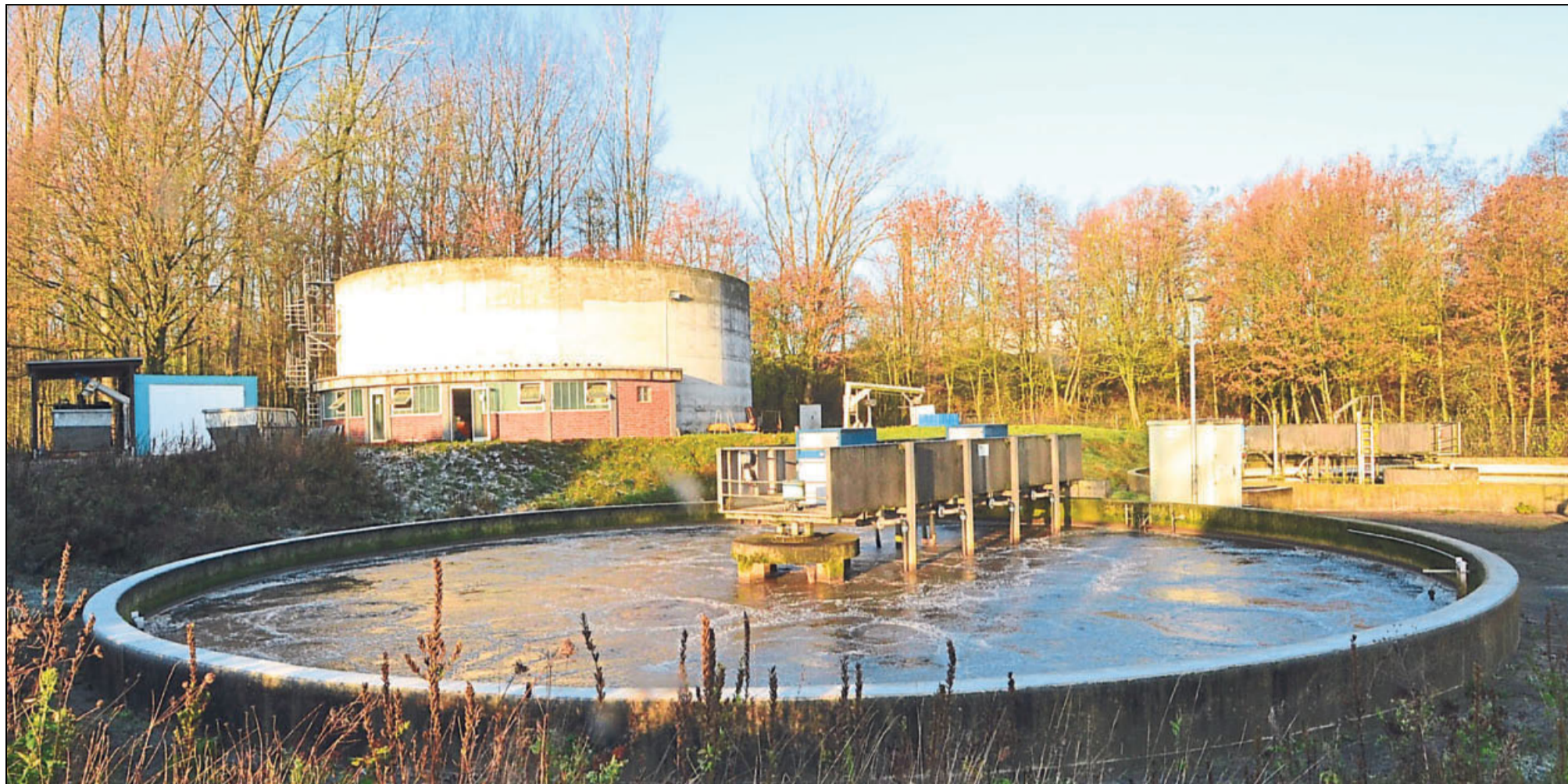
Blick auf die Kläranlage am Schwarzbach, die für rund 5,8 Millionen Euro (5,1 Mio davon zahlt die Stadt selbst) ausgebaut wird. Die Abwasserbehandlung soll so zukunftsfest gemacht werden.
