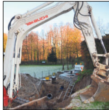
An der Zufahrt der Schwarzbach-Kläranlage wird derzeit bereits kräftig gebuddelt. Die Siegfriedstraße ist hier komplett gesperrt.
