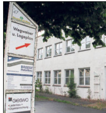
Blick auf den Eingang des Gewerbeparks, aus dem bereits vor Jahren die Mieter ausgezogen sind. Foto: Küppers
