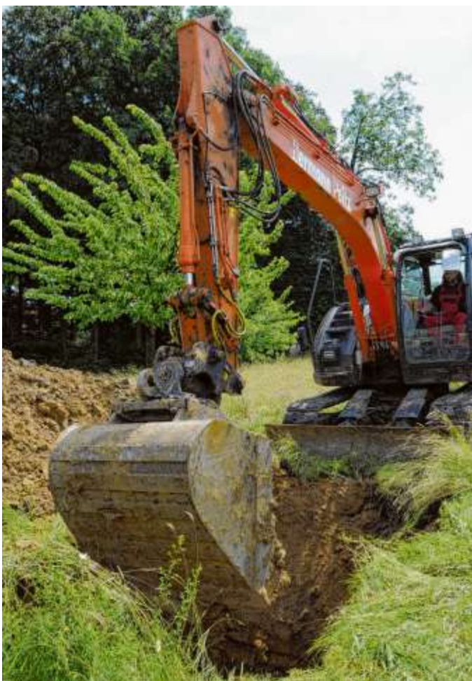
Baugrunderkundung: Um festzustellen, wie der Boden beschaffen ist, in den das neue Museum eingelassen werden soll, wurde gestern ein vier Meter tiefes Loch ausgehoben. „Kein separates Filtersystem nötig“, stellten die Fachleute erleichtert fest. FOTO: A. HANNEFORTH
