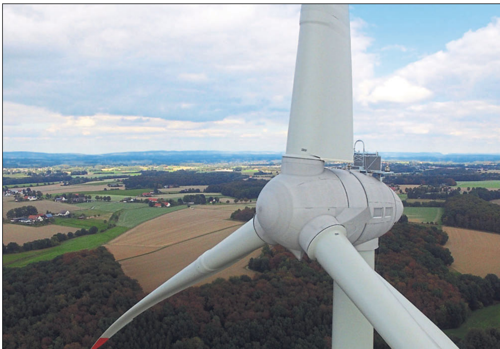
Das Windrad in Rotenhagen ist just fertig, 2017 soll schon der Bau einer ähnlichen Anlage südlich von Häger beginnen.
