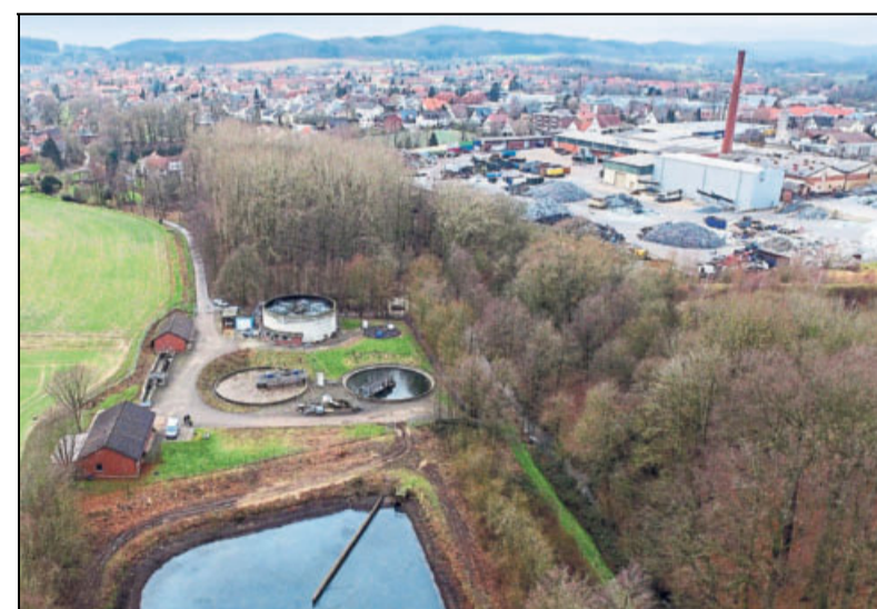
Die Kläranlage Schwarzbach wird ausgebaut. Die Investition wird auf 6,54 Millionen Euro geschätzt. Foto: Ulrich Falker
