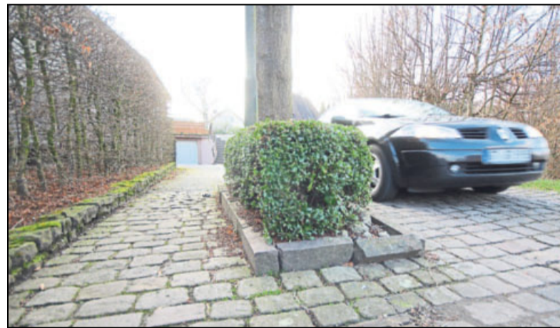
Eine mögliche Lösung an der Ecke Wellenpöhlen und Jahnstraße: Eine Baumscheibe trennt Fahrbahn und Gehweg. Der ist aber dennoch mit Kopfsteinen gepflastert und deshalb holprig.
